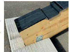
Abbildung 5. Auflager mit U-Profil
