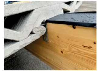
Abbildung 7. Lagesicherung Betonmodule
