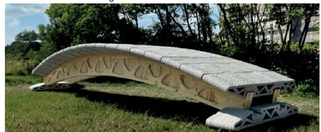
Abbildung 8. additive Betonbrücke mit Holzbogenkonstruktion
