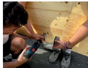
Abbildung 6. Anschluss Querbalken
