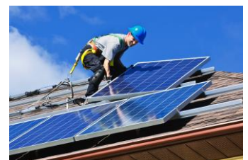
Installation von Solarpaneelen für die Energieerzeugung (Quelle: ubergizmo.com)
