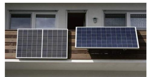
Abb. 1: Senkrecht und geneigte Module einer Plug-and-Play PV-Anlage an einem Balkongeländer (www.cleantinking.de)
