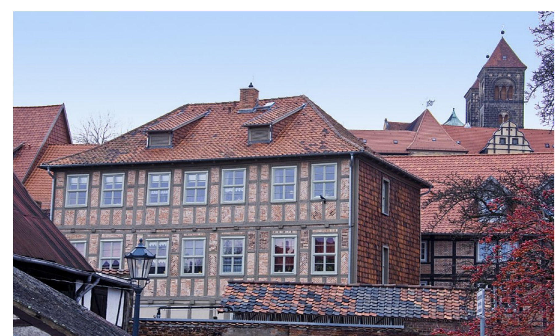
Abb. 4: Nordfassade (Hofseite) nach der Sanierung
