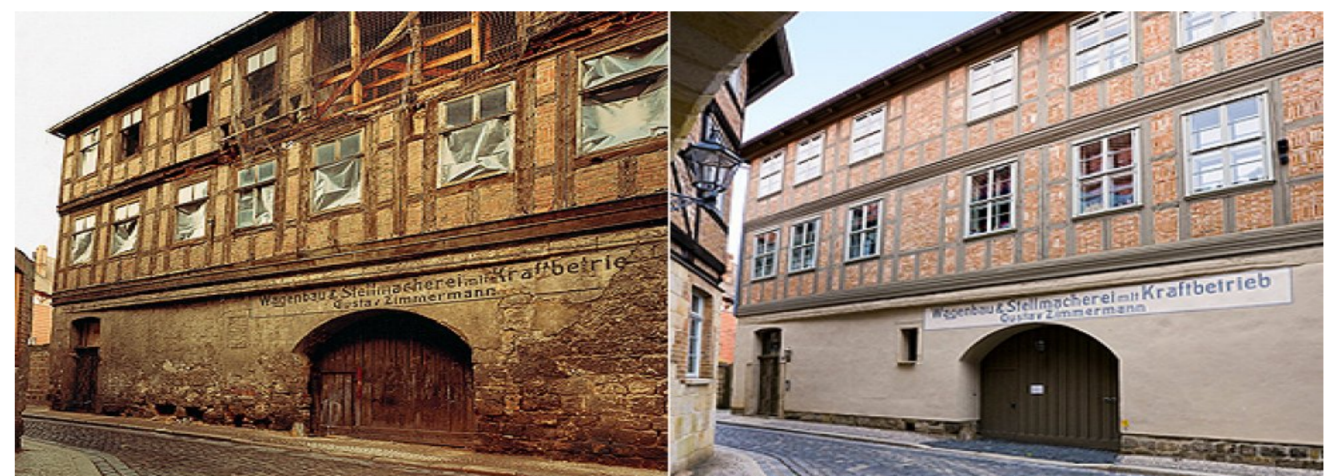
Abb. 3: Südfassade (Straßenseite) vor und nach der Sanierung
