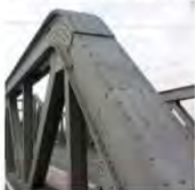
Bild 8: Genietete Brückenkonstruktion [11]
